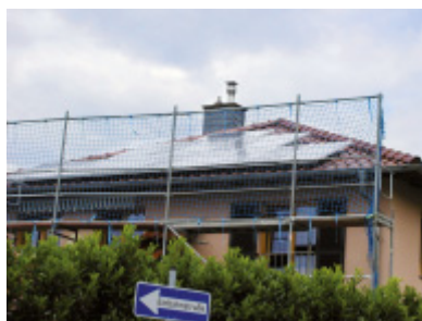
Fangerüst mit über den Arbeitsbereich hinausreichendem Fangnetz
