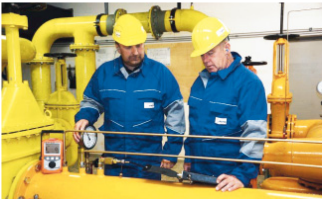
Abbildung 1: Arbeiten an einer Gasanlage
