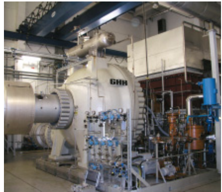
Abbildung 4: Maschinenhalle Erdgas-Verdichter
