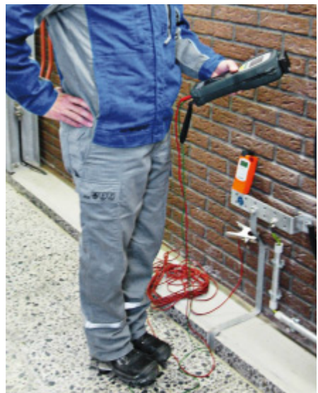
Abbildung 6: Durchführung der Fußbodenmessung
